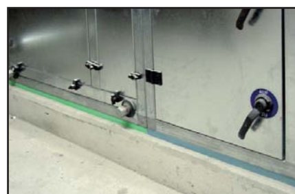
Klimatizační jednotky uložené na pružky Sylomeru
