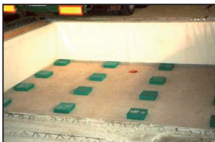
Terčové (bodové) uložení konstrukce základu
